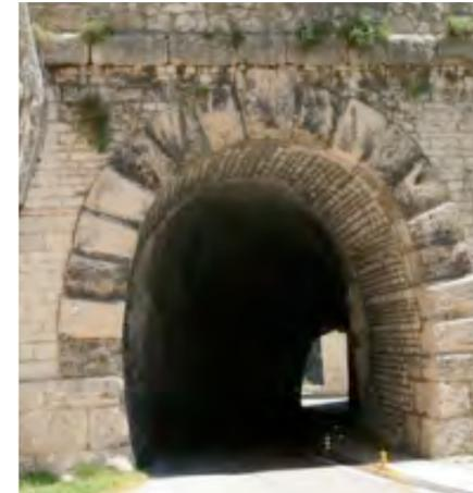
Una importante galleria stradale viene eseguita al Furlo, lungo la via Salaria, sotto l'imperatore Vespasiano, nel 76-77 d.C.. La galleria è ancora funzionante, sia pure sostanzialmente rimodernata. Questo passaggio stradale in sotterraneo era già stata eseguita, su scala ridotta, nel 300 a.C., ed il progetto di Vespasiano si limita a riconsolidare ed ingrandire la galleria preesistente.
