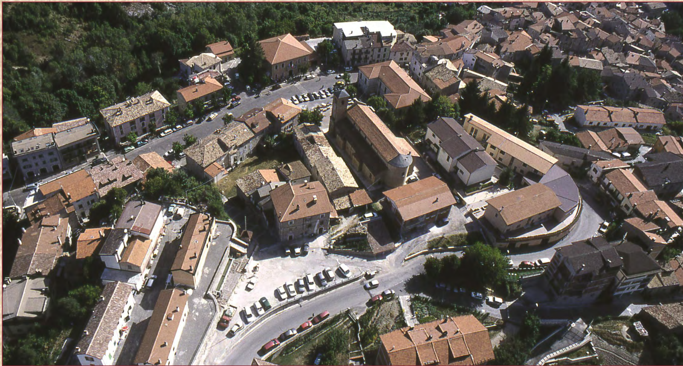
Cappadocia, veduta aerea del centro storico Archivio della Comunità Montana Marsica 1
