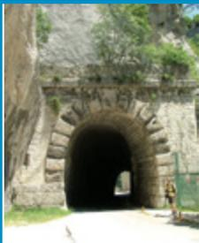
Una importante galleria stradale viene eseguita al Furlo, lungo la via Salaria, sotto l'imperatore Vespasiano, nel 76-77 d.C.. La galleria è ancora funzionante, sia pure sostanzialmente rimodernata. Questo passaggio stradale in sottterraneo era già stata eseguita, su scala ridotta, nel 300 a.C., ed il progetto di Vespasiano si limita a riconsolidare ed ingrandire la galleria preesistente.
